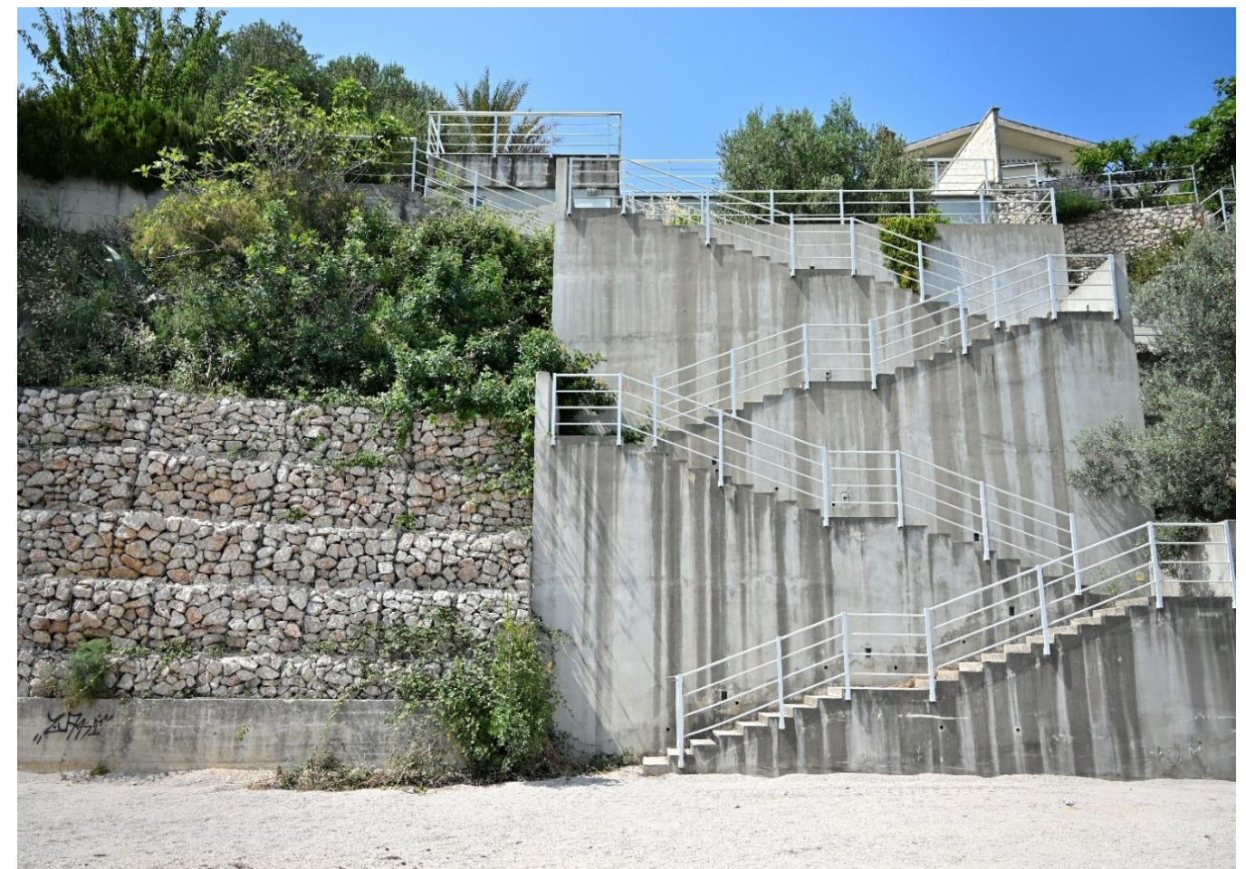
Sl. 93. Padina uz obalu u Posedarju koja je betonirana uslijed podločnosti klizanju (gore); gabionska stabilizacija padine uz betonske stepenice za pristup plaži (dolje)
