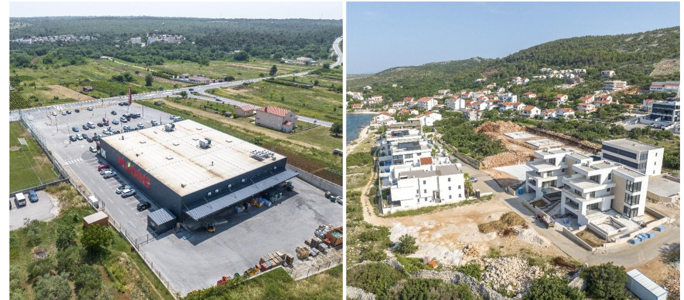
Sl. 69. Ravni krov i građevinska čestica s minimalnim udjelom zelenila trgovine Plodina (lijevo); apartmanski kompleks u izgradnji u Vinjercu (desno)
